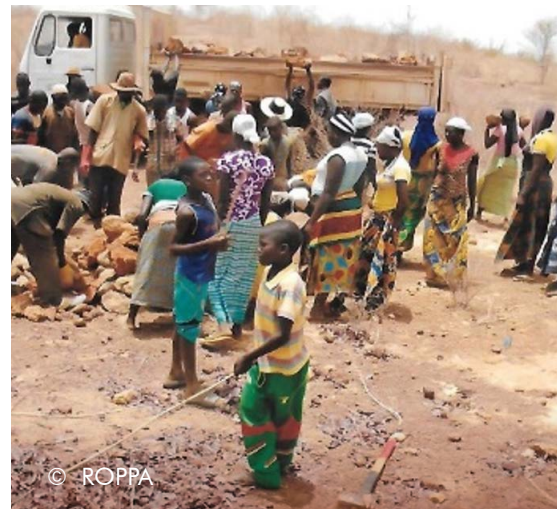
Ramassage de moellons pour la réalisation de cordons pierreux
