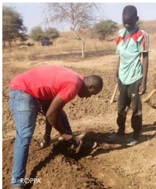
Mise en place de billons renforcés
