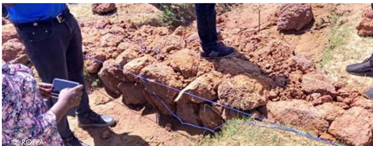
Mise en place de cordons pierreux
