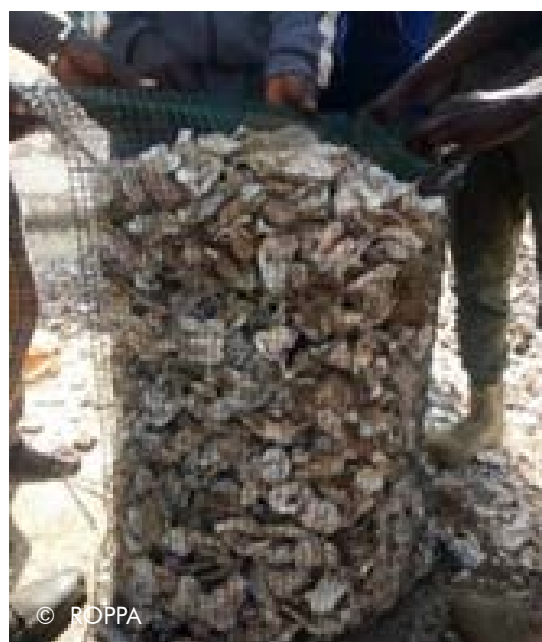
Gabion à base de coquilles d'huîtres
