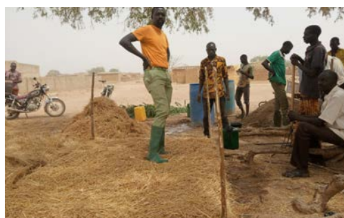
Montage d'une première couche
